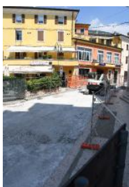
Centro chiuso per lavori FotoPecora
